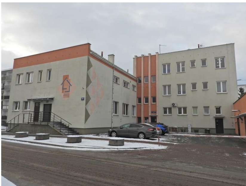
Ryc. 3. Widok na budynek główny od strony wschodniej.
