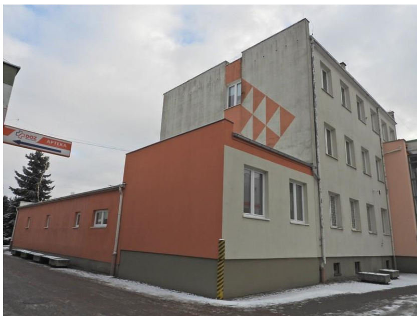
Ryc. 5. Widok na przybudówkę i budynek główny (od strony północno-zachodniej).
