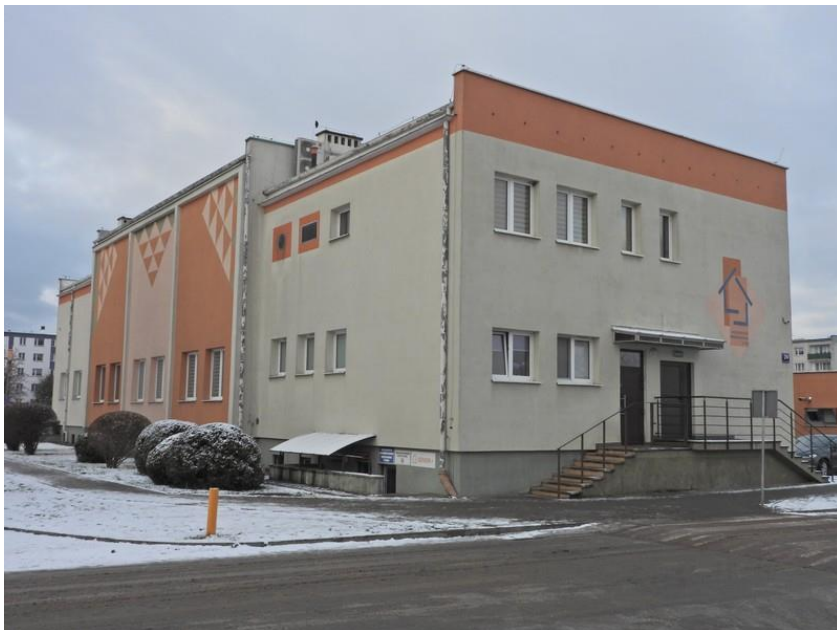
Ryc. 2. Widok na budynek od strony południowo-wschodniej.
