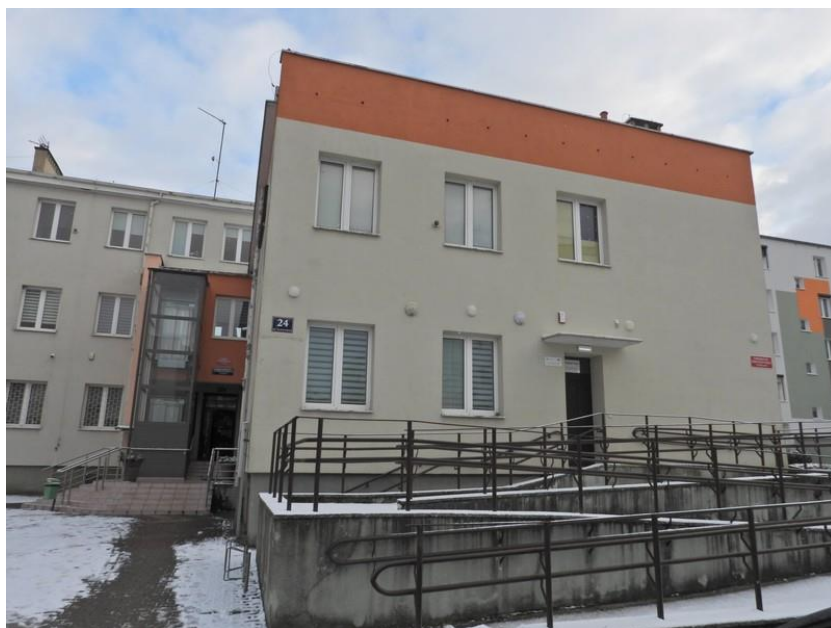
Ryc. 6. Widok na budynek główny od strony północnej.
