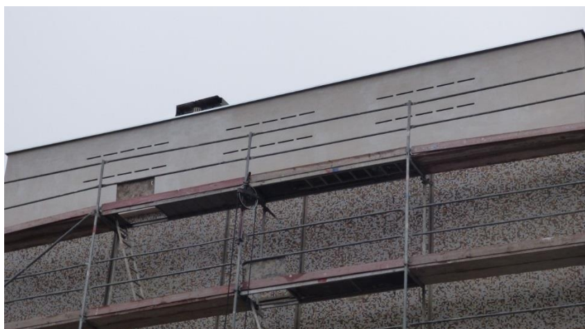
Ryc. 76. Budki podtynkowe dla nietoperzy – przykład ściany bloku z 30 dużymi budkami dla nietoperzy.
