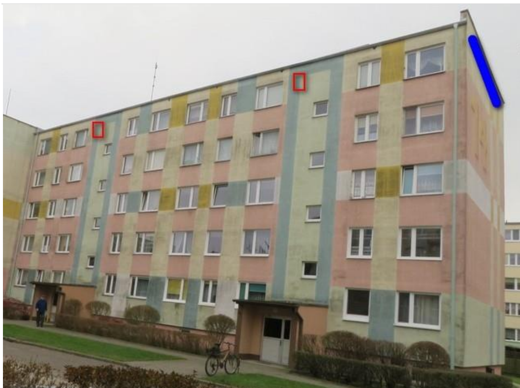
Ryc. 63. Miejsce zawieszenia skrzynek lęgowych dla kawki (czerwone prostokąty) na ścianie północnej oraz skrzynek podtynkowych dla nietoperzy (niebieska linia) na ścianie zachodniej.
