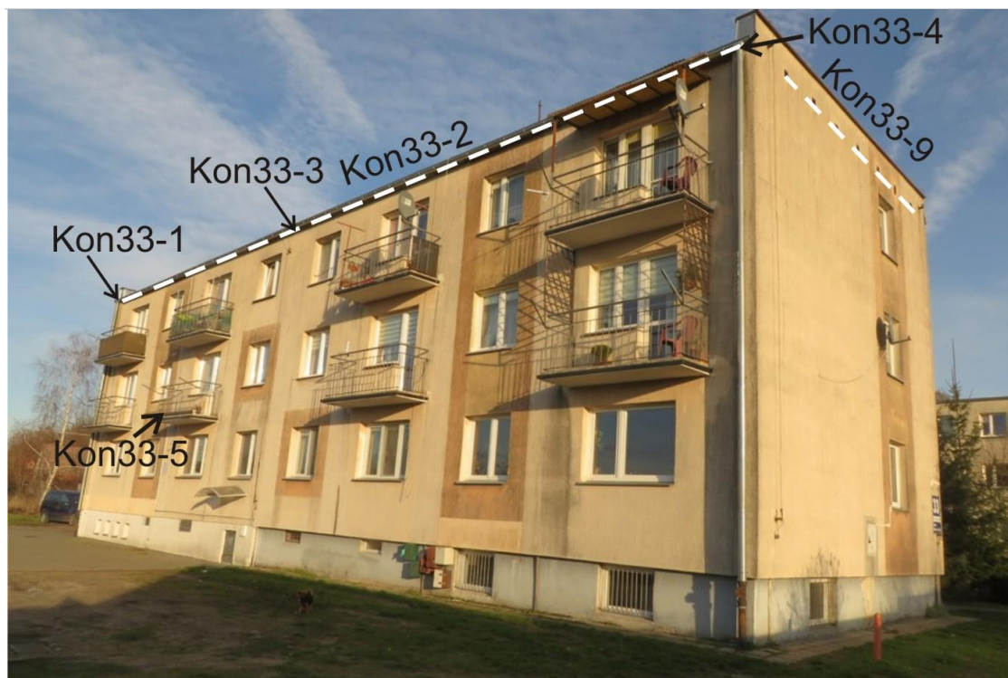
Ryc. 8. Ściana południowa i zachodnia budynku na ul. Konopnickiej 33 z zaznaczeniem pozycji opisanych w tekście
