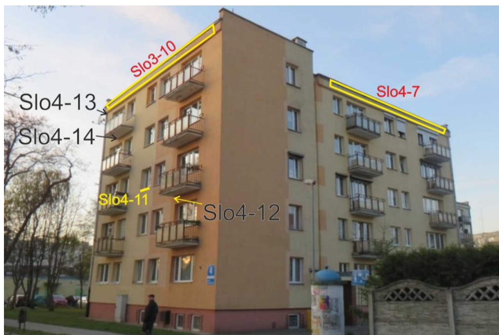
Ryc. 22. Ściany południowo-wschodniej budynku na os. Słowackiego 4 z zaznaczeniem pozycji opisanych w tekście
