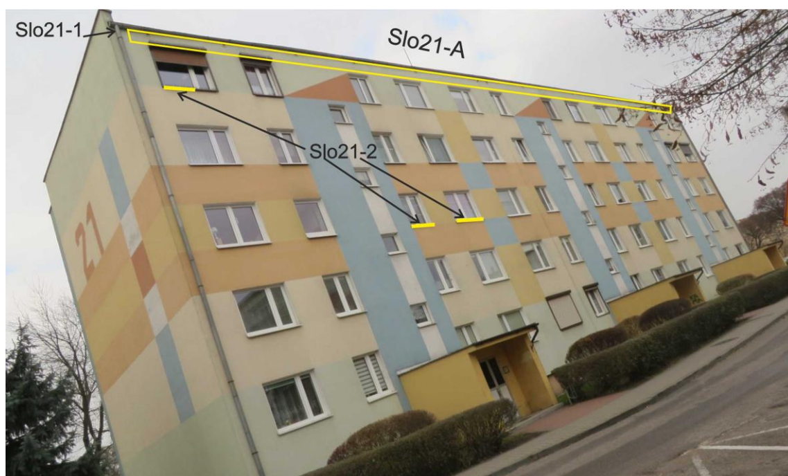
Ryc. 32. Część południowo-wschodnia budynku na os. Słowackiego 21 z zaznaczeniem pozycji opisanych w tekście
