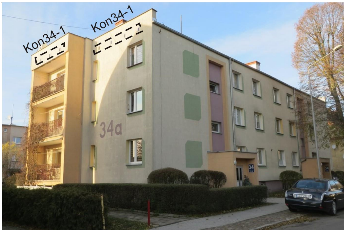
Ryc. 10. Ściana południowa i wschodnia budynku na ul. Konopnickiej 34A z zaznaczeniem pozycji opisanych w tekście
