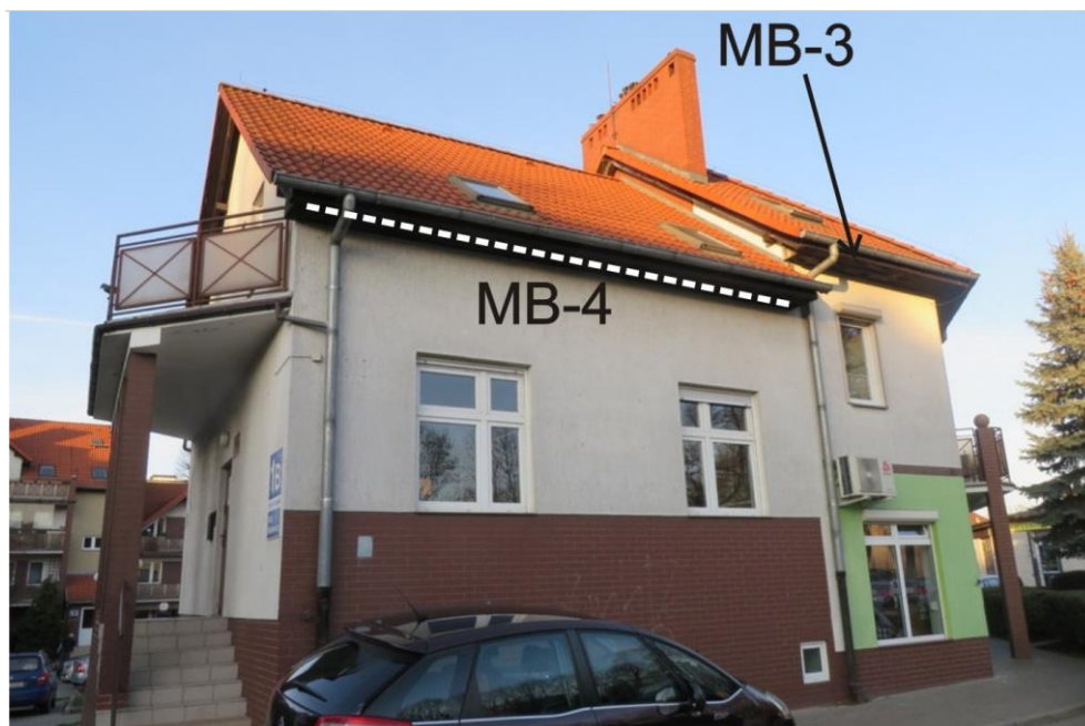
Ryc. 15. Ściany południowa budynku na ul. Mickiewicza 1B z zaznaczeniem pozycji opisanych w tekście
