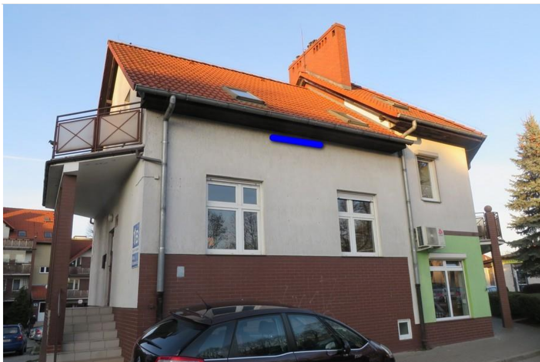
Ryc. 64. Miejsce zawieszenia skrzynek podtynkowych dla nietoperzy (niebieska linia) na ścianie południowej.
