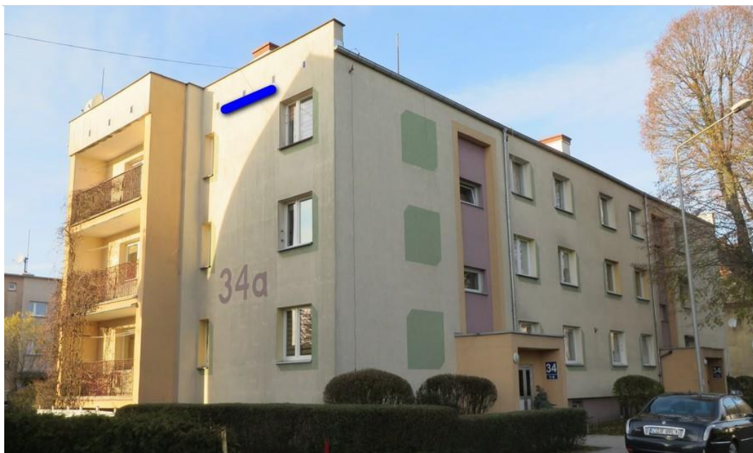
Ryc. 60. Miejsce zawieszenia skrzynek podtynkowych dla nietoperzy (niebieska linia) na ścianie południowej.
