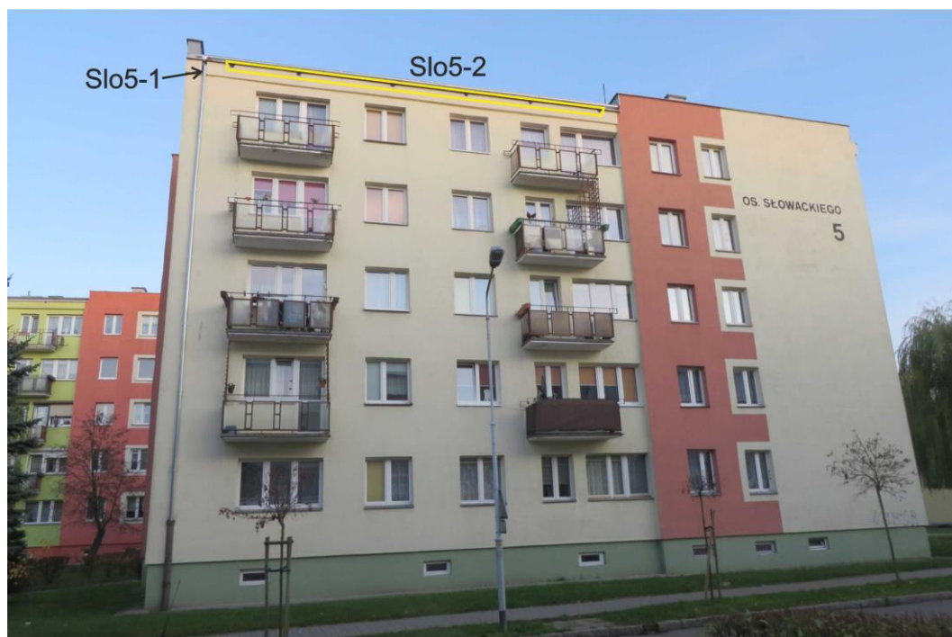
Ryc. 26. Ściany zachodnia budynku na os. Słowackiego 5 z zaznaczeniem pozycji opisanych w tekście
