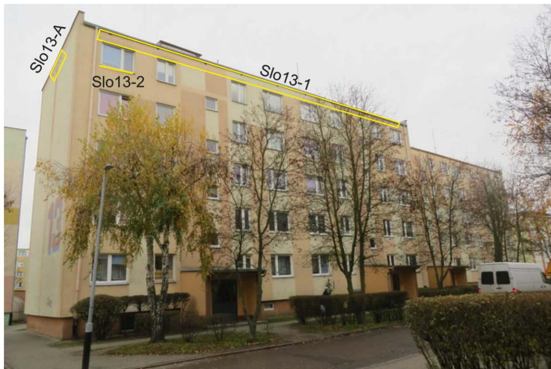
Ryc. 30. Część południowo-wschodnia budynku na os. Słowackiego 13 z zaznaczeniem pozycji opisanych w tekście
