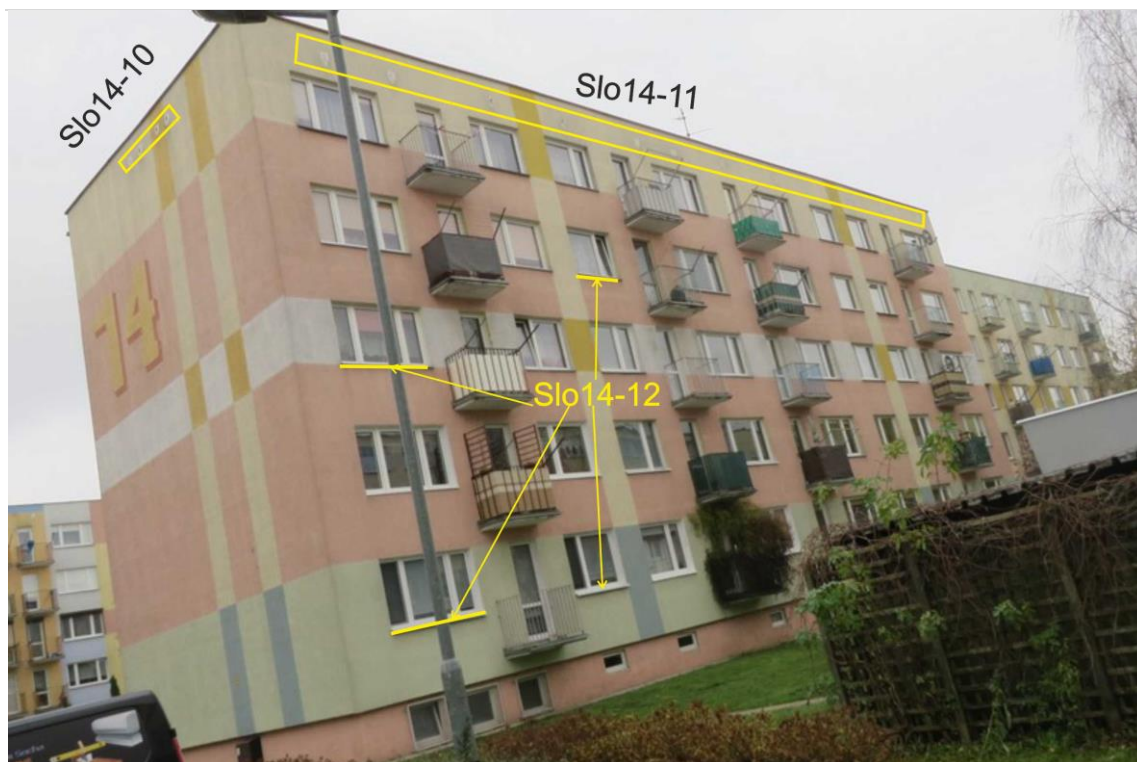
Ryc. 36. Część południowo-zachodnia budynku na os. Słowackiego 14 z zaznaczeniem pozycji opisanych w tekście
