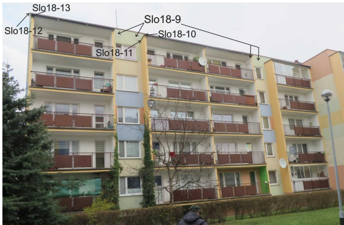
Ryc. 34. Część południowo-zachodnia budynku na os. Słowackiego 18 z zaznaczeniem pozycji opisanych w tekście
