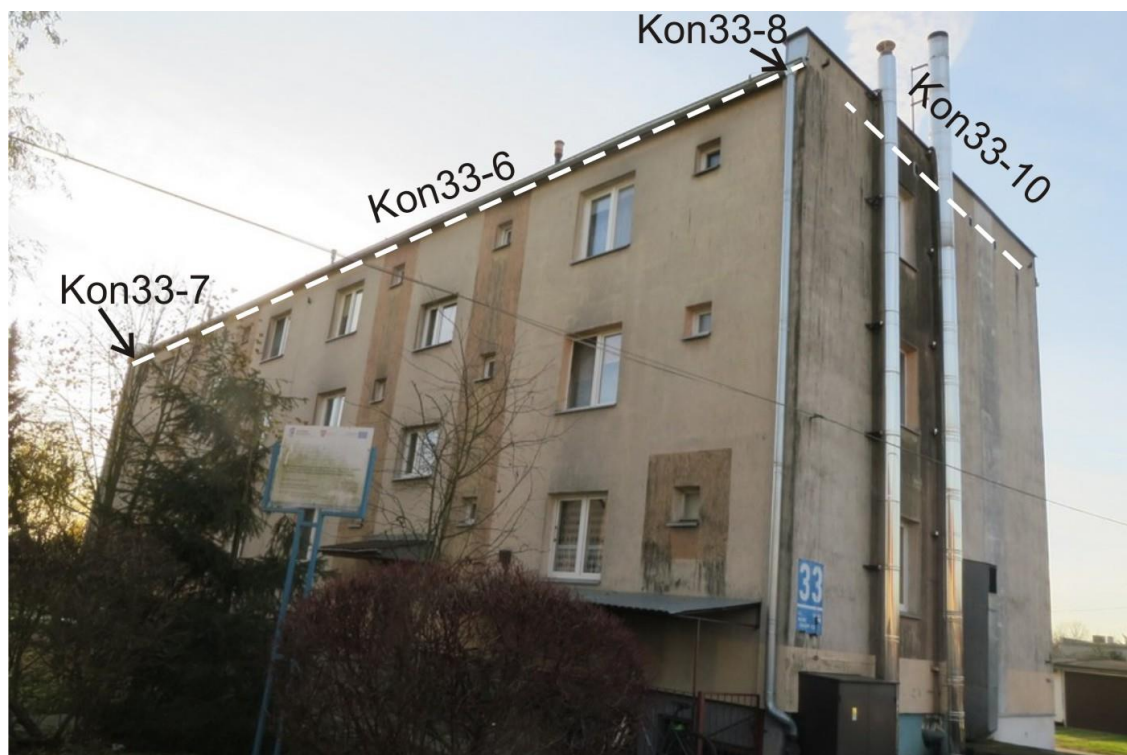
Ryc. 7. Ściany północna i wschodnia budynku na ul. Konopnickiej 33 z zaznaczeniem pozycji opisanych w tekście
