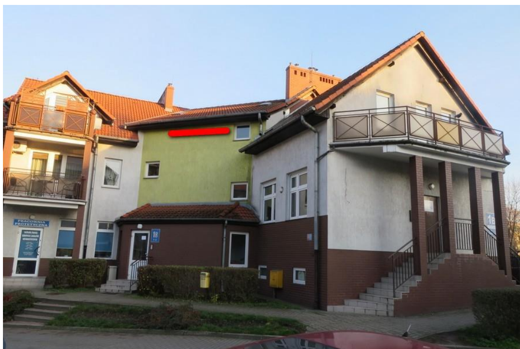
Ryc. 63. Miejsce zawieszenia skrzynek lęgowych dla jerzyka na ścianie północnej (czerwona linia).
