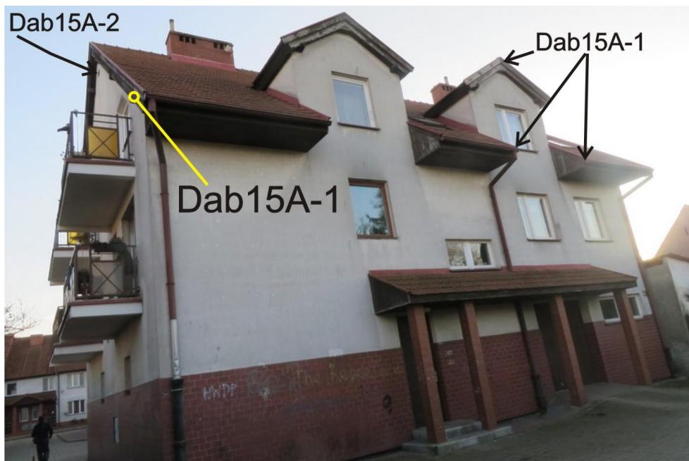
Ryc. 3. Ściany północna i wschodnia budynku na ul. Dąbrowskiego 15A z zaznaczeniem pozycji opisanych w tekście
