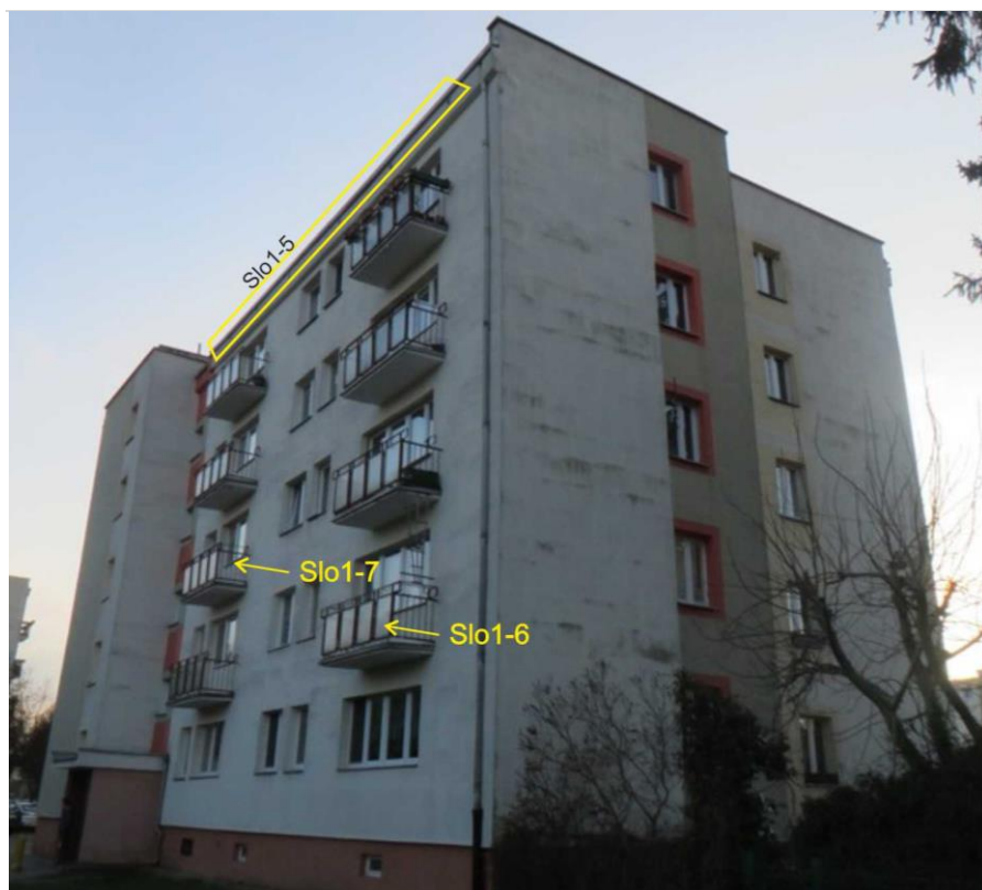
Ryc. 18. Ściany północna i wschodnia budynku na os. Słowackiego 1 z zaznaczeniem pozycji opisanych w tekście
