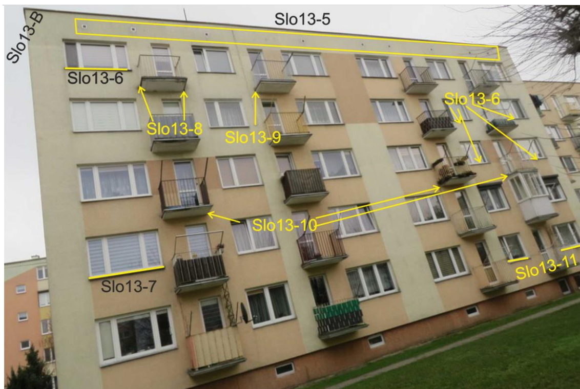
Ryc. 32. Część północno-zachodnia budynku na os. Słowackiego 13 z zaznaczeniem pozycji opisanych w tekście
