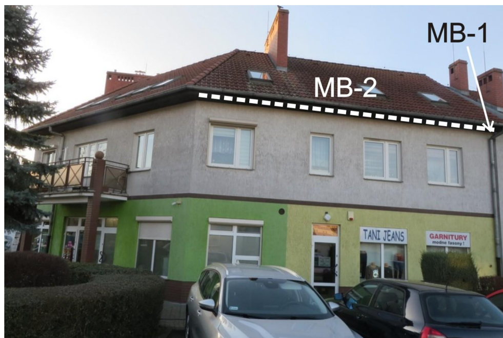
Ryc. 14. Ściany wschodnia budynku na ul. Mickiewicza 1B z zaznaczeniem pozycji opisanych w tekście
