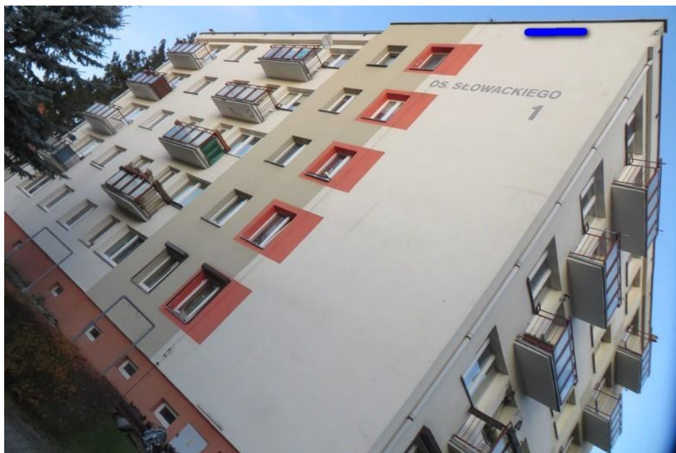
Ryc. 66. Miejsce zawieszenia skrzynek podtynkowych dla nietoperzy (niebieska linia) na ścianie zachodniej.
