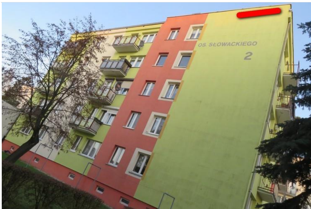
Ryc. 69. Miejsce zawieszenia skrzynek podtynkowych dla nietoperzy (czerwona linia) na ścianie zachodniej.
