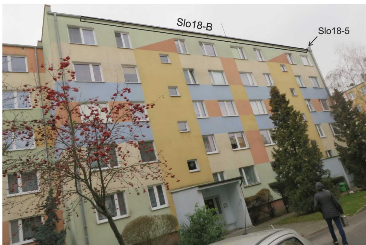
Ryc. 33. Część północno-zachodnia budynku na os. Słowackiego 18 z zaznaczeniem pozycji opisanych w tekście
