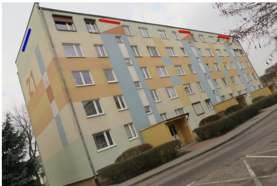
Ryc. 66. Miejsce zawieszenia skrzynek dla jerzyka na ścianie wschodniej (czerwone linie) oraz skrzynek podtynkowych dla nietoperzy (niebieska linia) na ścianie południowej.
