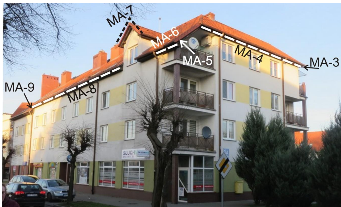
Ryc. 13. Ściany południowa i zachodnia budynku na ul. Mickiewicza 1A z zaznaczeniem pozycji opisanych w tekście
