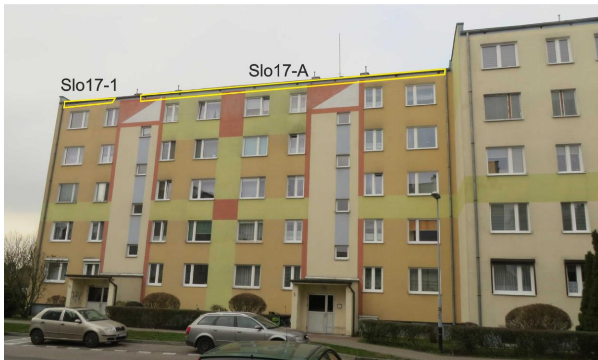
Ryc. 32. Część południowo-wschodnia budynku na os. Słowackiego 17 z zaznaczeniem pozycji opisanych w tekście
