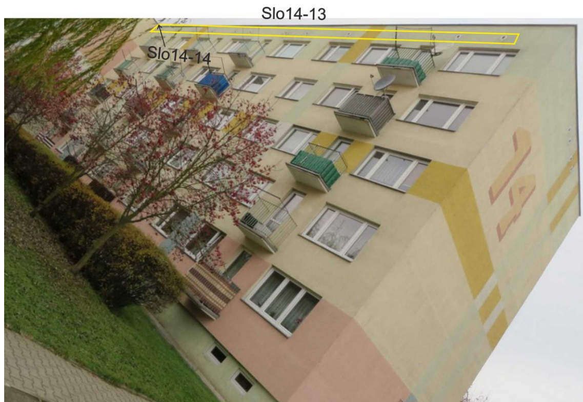
Ryc. 37. Część południowo-wschodnia budynku na os. Słowackiego 14 z zaznaczeniem pozycji opisanych w tekście
