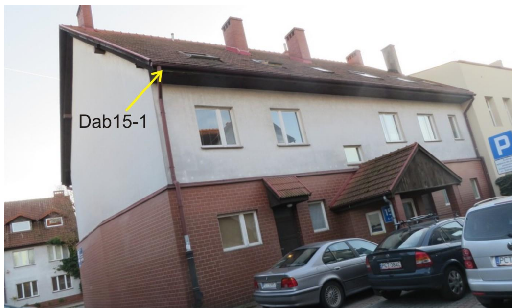
Ryc. 1. Ściany północna i wschodnia budynku na ul. Dąbrowskiego 15 z zaznaczeniem pozycji opisanych w tekście
