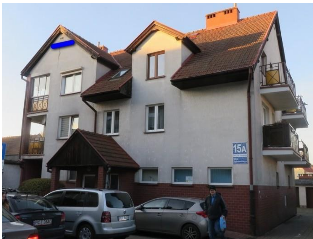
Ryc. 53. Miejsce zawieszenia skrzynek podtynkowych dla nietoperzy (niebieska linia) na ścianie południowej.
