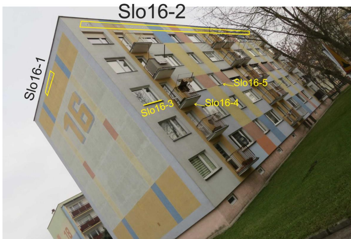
Ryc. 38. Część południowo-zachodnia budynku na os. Słowackiego 16 z zaznaczeniem pozycji opisanych w tekście
