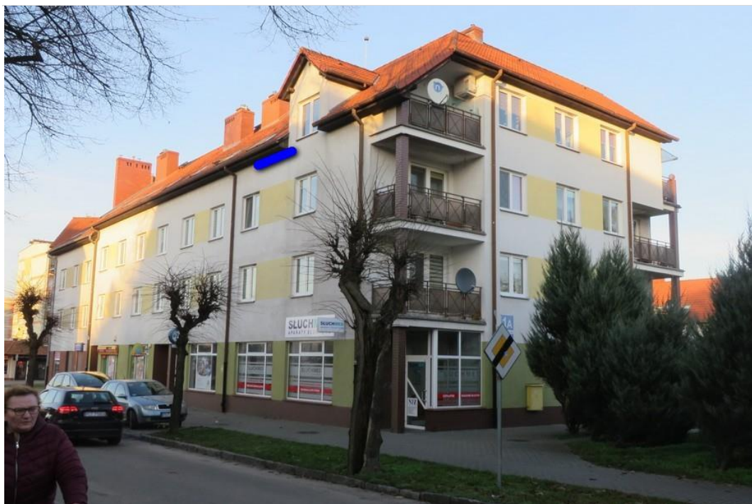
Ryc. 62. Miejsce zawieszenia skrzynek podtynkowych dla nietoperzy (niebieska linia) na ścianie zachodniej.
