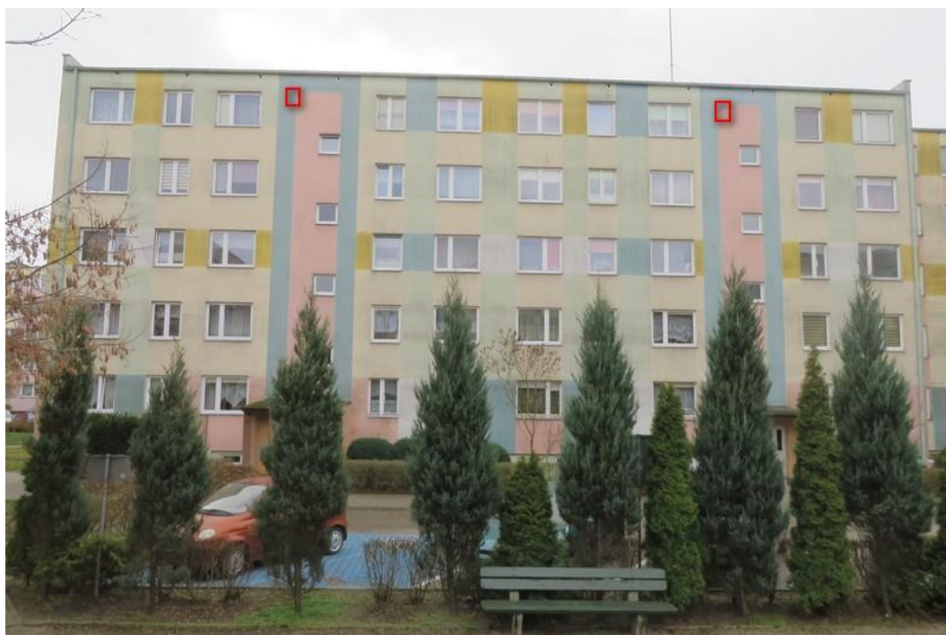
Ryc. 63. Miejsce zawieszenia skrzynek lęgowych dla kawki (czerwone prostokąty) na ścianie północnej.
