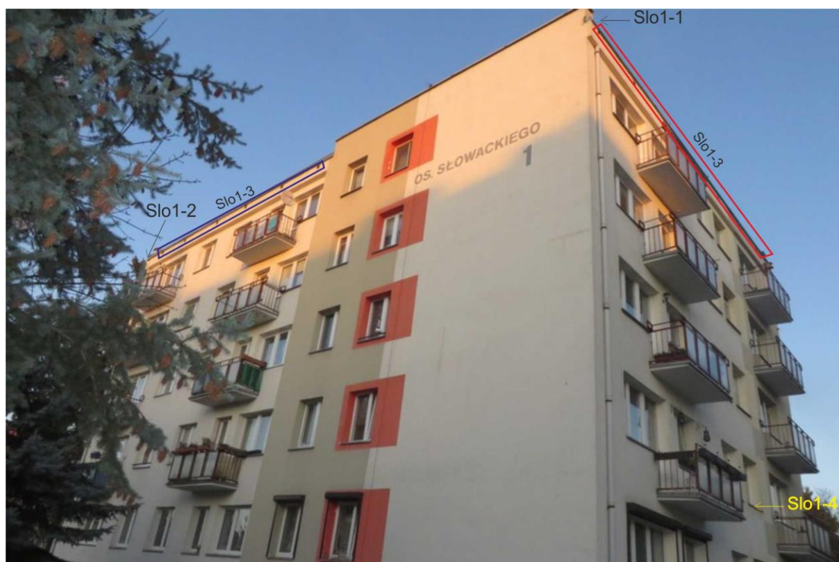
Ryc. 17. Ściany południowa i zachodnia budynku na os. Słowackiego 1 z zaznaczeniem pozycji opisanych w tekście
