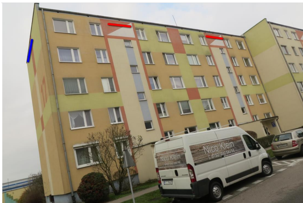
Ryc. 73. Miejsce zawieszenia skrzynek lęgowych jerzyków (czerwone linie) na ścianie wschodniej i skrzynek podtynkowych dla nietoperzy na ścianie południowej.
