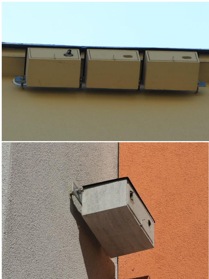
Ryc. 74. Przykładowy sposób zamocowania budek trocinobetonowych do budynku – za pomocą płaskownika i prętów. Pierwsza od lewej budka dla jeryzka oraz dolna lewa budka zajęta jest przez wróbla.
