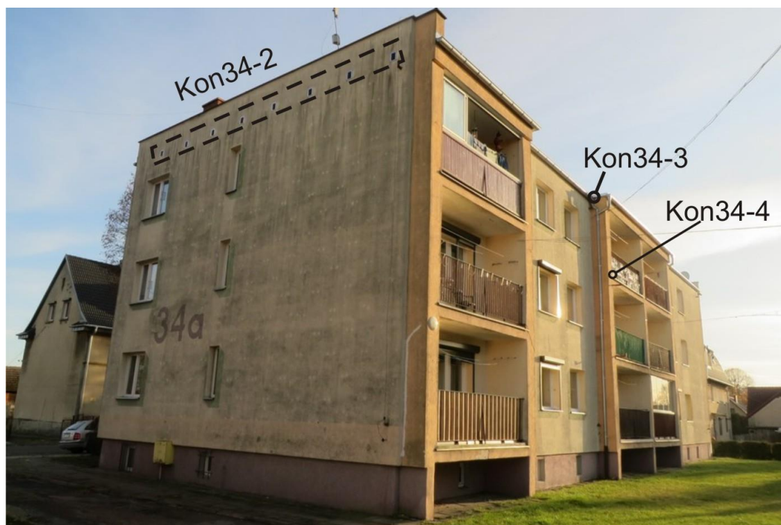
Ryc. 9. Ściany północna i zachodnia budynku na ul. Konopnickiej 34A z zaznaczeniem pozycji opisanych w tekście
