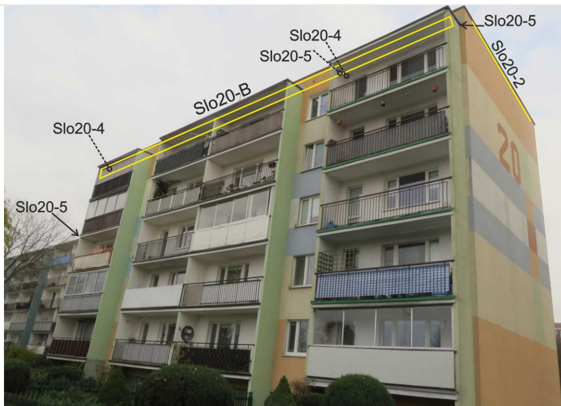
Ryc. 33. Część południowo-wschodnia budynku na os. Słowackiego 19 z zaznaczeniem pozycji opisanych w tekście
