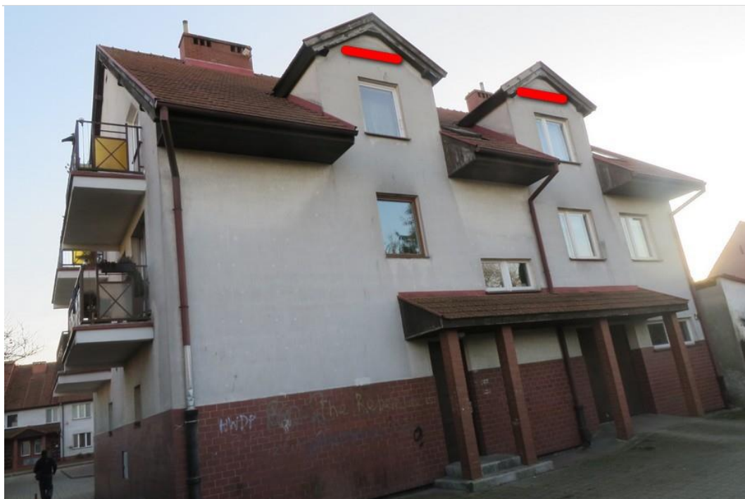
Ryc. 52. Miejsce zawieszenia skrzynek lęgowych dla jerzyka na ścianie północnej (czerwona linia).
