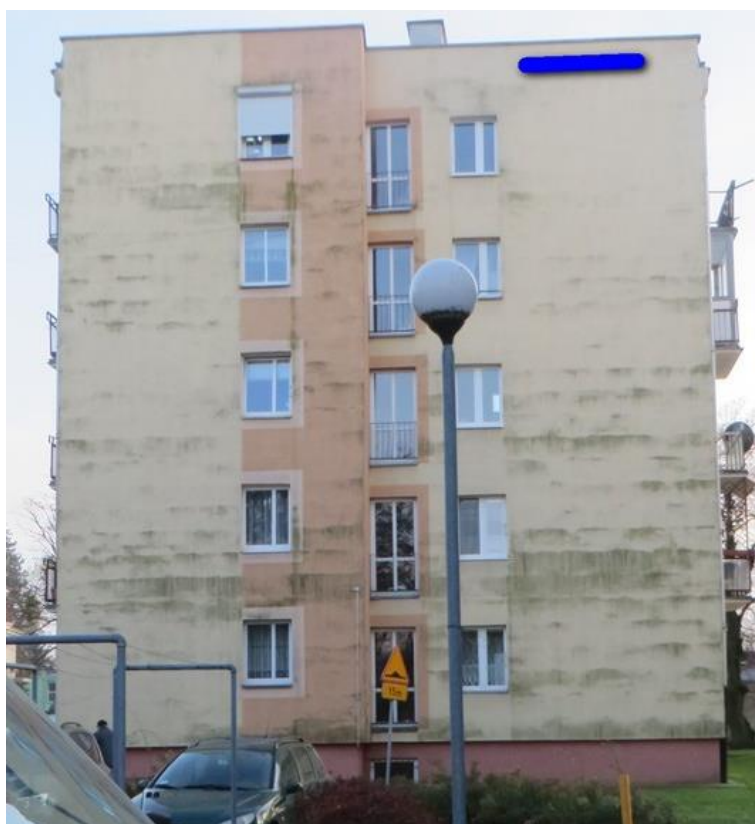
Ryc. 60. Miejsce zawieszenia skrzynek podtynkowych dla nietoperzy (niebieska linia) na ścianie południowej.
