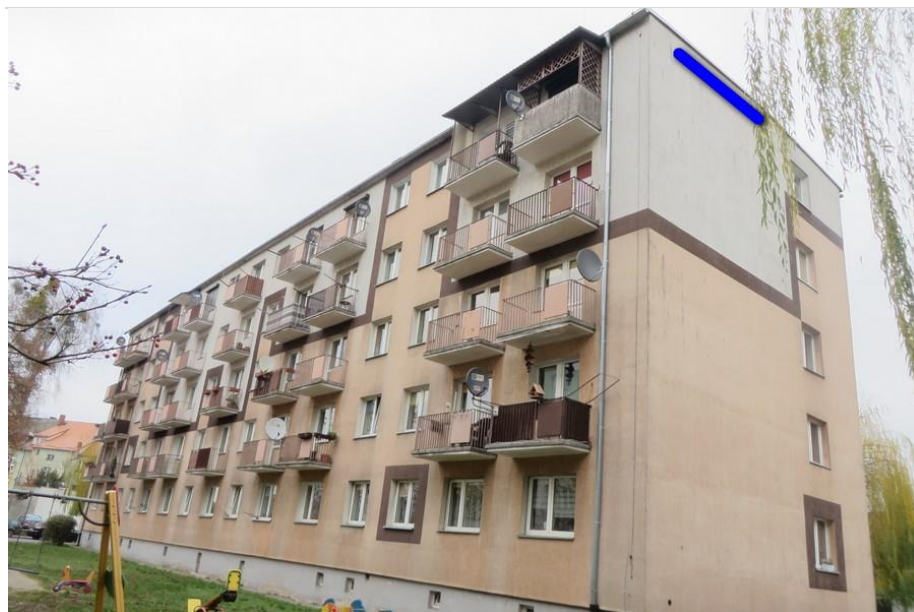
Ryc. 66. Miejsce zawieszenia skrzynek lęgowych dla nietoperzy (niebieska linia) na ścianie południowej.
