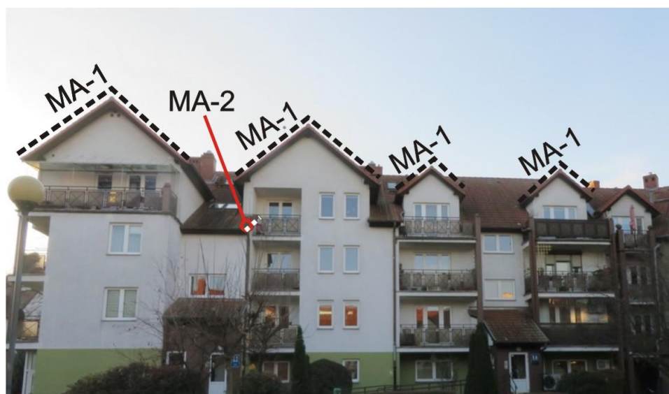
Ryc. 12. Ściany wschodnia budynku na ul. Mickiewicza 1A z zaznaczeniem pozycji opisanych w tekście
