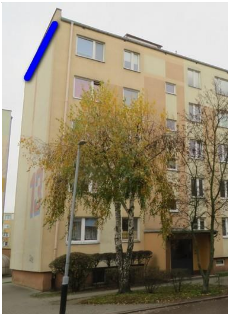
Ryc. 60. Miejsce zawieszenia skrzynek podtynkowych dla nietoperzy (niebieska linia) na ścianie południowej.
