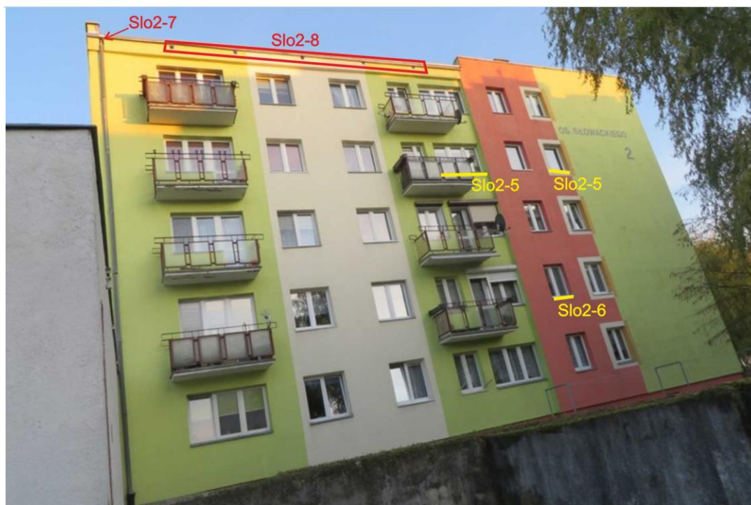
Ryc. 20. Ściany zachodnia budynku na os. Słowackiego 2 z zaznaczeniem pozycji opisanych w tekście
