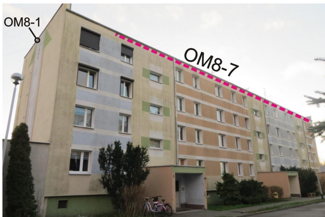
Ryc. 42. Ściany północna i wschodnia budynku na os. Młodych 8 z zaznaczeniem pozycji opisanych w tekście
