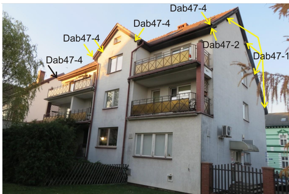
Ryc. 6. Ściana południowa i wschodnia budynku na ul. Dąbrowskiego 47 z zaznaczeniem pozycji opisanych w tekście
