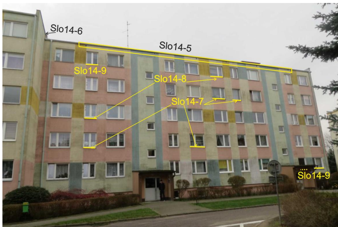
Ryc. 35. Część północno-zachodnia budynku na os. Słowackiego 14 z zaznaczeniem pozycji opisanych w tekście
