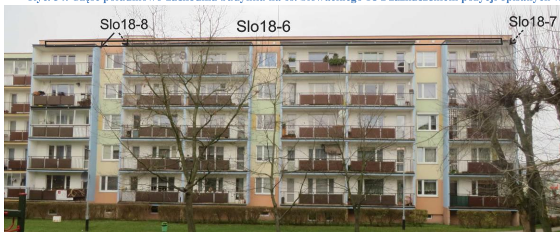
Ryc. 34. Część południowo-wschodnia budynku na os. Słowackiego 18 z zaznaczeniem pozycji opisanych w tekście
