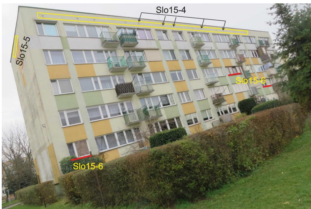
Ryc. 11. Część północno-zachodnia budynku na os. Słowackiego 15 z zaznaczeniem pozycji opisanych w tekście
