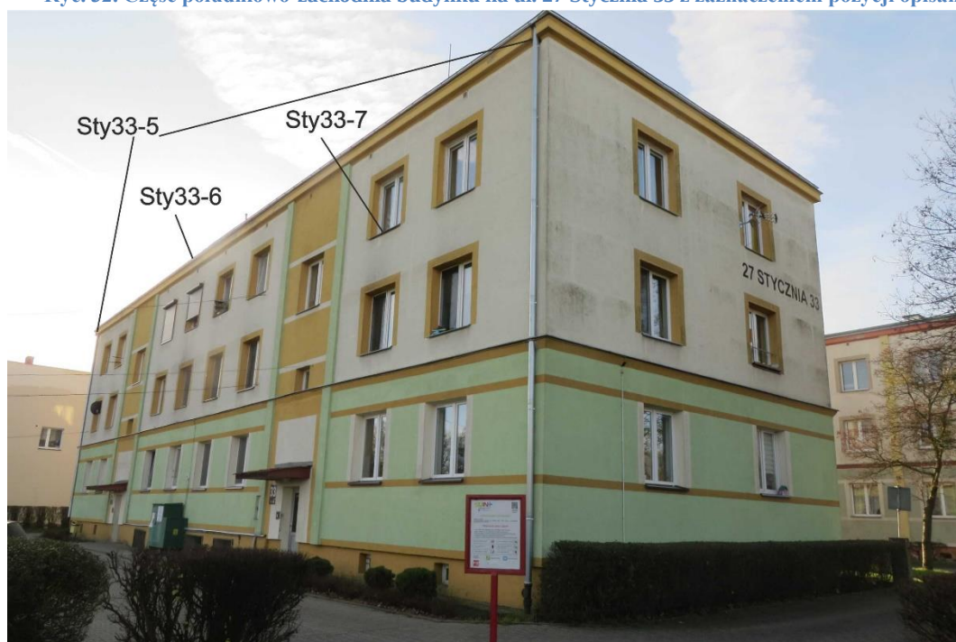
Ryc. 33. Część północno-wschodnia budynku na ul. 27 Stycznia 33 z zaznaczeniem pozycji opisanych w tekście
