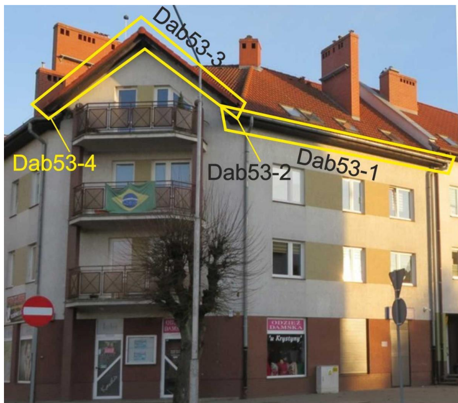
Ryc. 32. Część północno-zachodnia budynku na ul. Dąbrowskiego 53 z zaznaczeniem pozycji opisanych w tekście.
