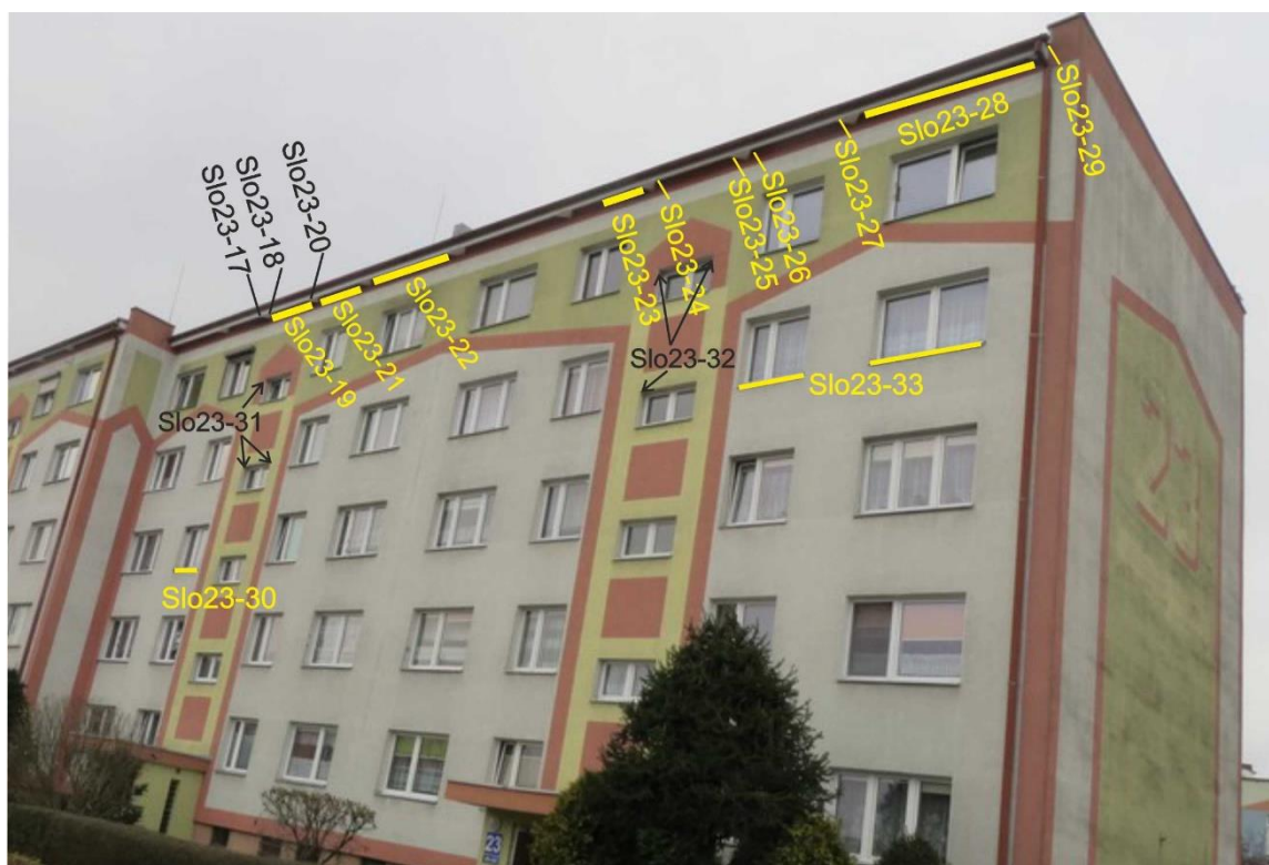
Ryc. 33. Część północno-wschodnia budynku na os. Słowackiego 23 z zaznaczeniem pozycji opisanych w tekście
