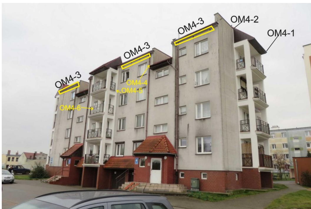
Ryc. 34. Część północno-zachodnia budynku na Os. Młodych 4 z zaznaczeniem pozycji opisanych w tekście
