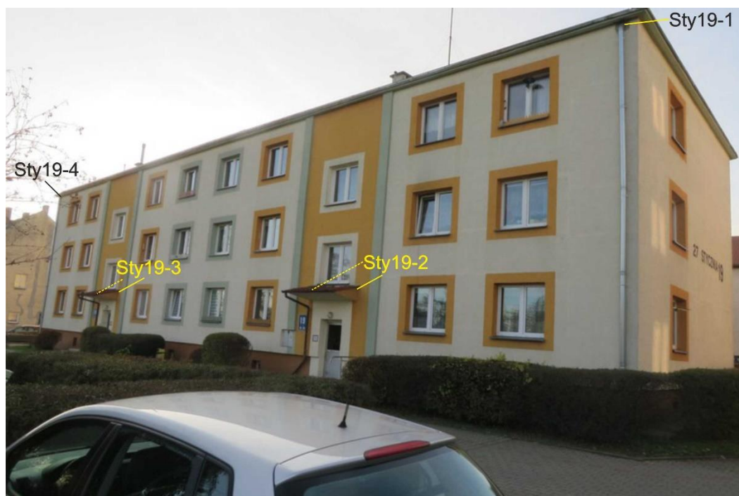
Ryc. 32. Część północno-wschodnia budynku na ul. 27 Stycznia 19 z zaznaczeniem pozycji opisanych w tekście
