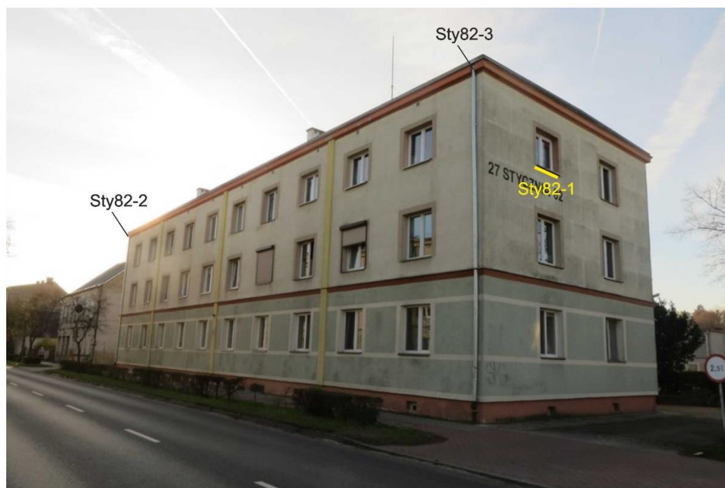
Ryc. 32. Część południowo-wschodnia budynku na ul. 27 Stycznia 82 z zaznaczeniem pozycji opisanych w tekście
