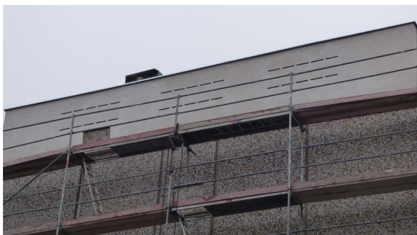
Ryc. 47. Budki podtynkowe dla nietoperzy – przykład ściany bloku z 30 dużymi budkami dla nietoperzy.
