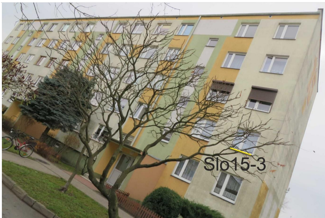
Ryc. 10. Część północno-wschodnia budynku na os. Słowackiego 15 z zaznaczeniem pozycji opisanych w tekście
