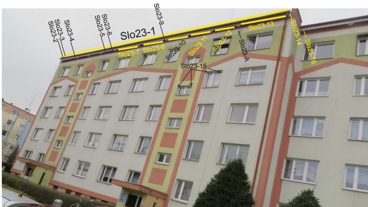
Ryc. 32. Część południowo-wschodnia budynku na os. Słowackiego 23 z zaznaczeniem pozycji opisanych w tekście
