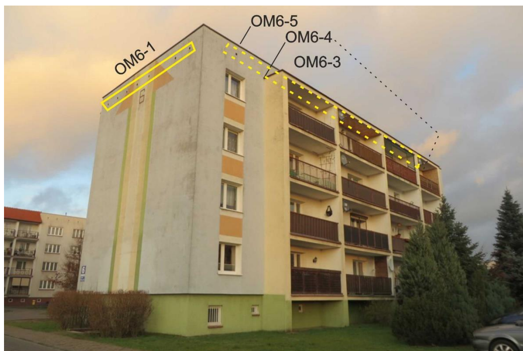
Ryc. 32. Część południowo-zachodnia budynku na Os. Młodych 6 z zaznaczeniem pozycji opisanych w tekście
