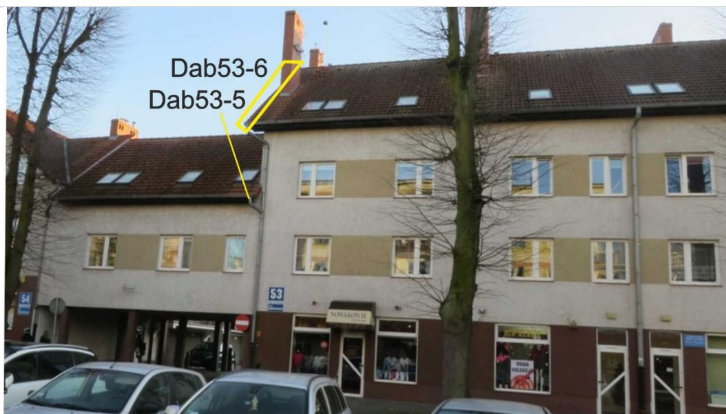
Ryc. 33. Część północno-wschodnia budynku na ul. Dąbrowskiego 53 z zaznaczeniem pozycji opisanych w tekście.
