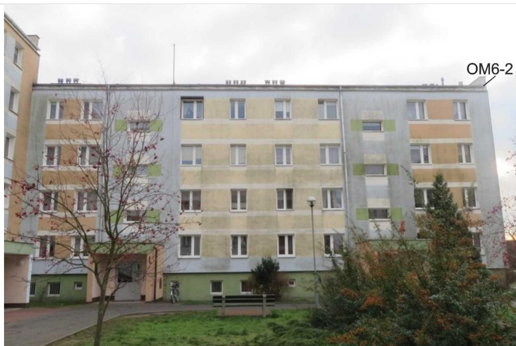
Ryc. 33. Część północna budynku na Os. Młodych 6 z zaznaczeniem pozycji opisanych w tekście
