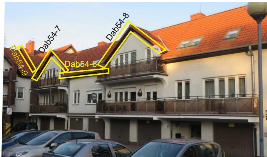
Ryc. 34. Część północno-zachodnia budynku na ul. Dąbrowskiego 54 z zaznaczeniem pozycji opisanych w tekście.
