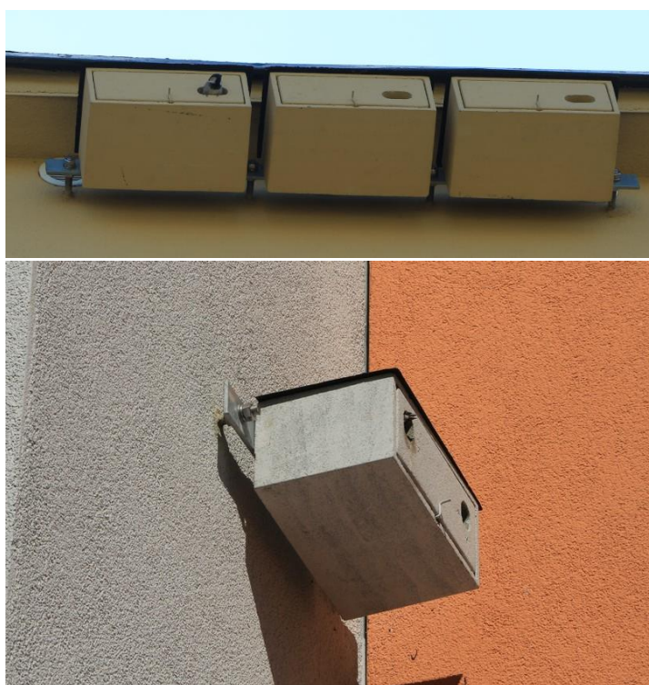
Ryc. 45. Przykładowy sposób zamocowania budek trocinobetonowych do budynku – za pomocą płaskownika i prętów gwintowanych.
