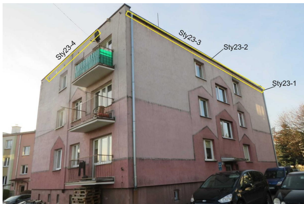
Ryc. 32. Część północno-wschodnia budynku na ul. 27 Stycznia 23 z zaznaczeniem pozycji opisanych w tekście
