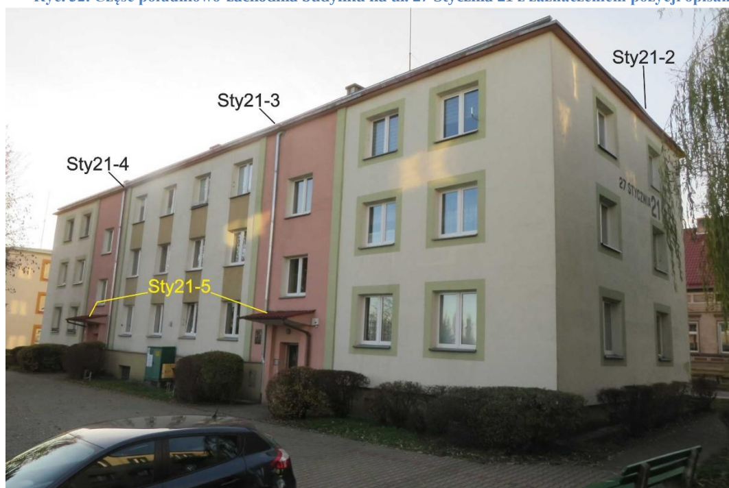
Ryc. 33. Część północno-wschodnia budynku na ul. 27 Stycznia 21 z zaznaczeniem pozycji opisanych w tekście
