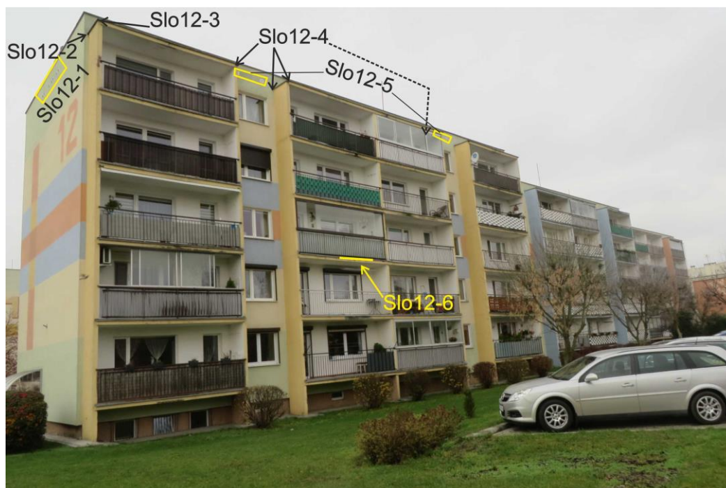
Ryc. 4. Część południowo-wschodnia budynku na os. Słowackiego 12 z zaznaczeniem pozycji opisanych w tekście
