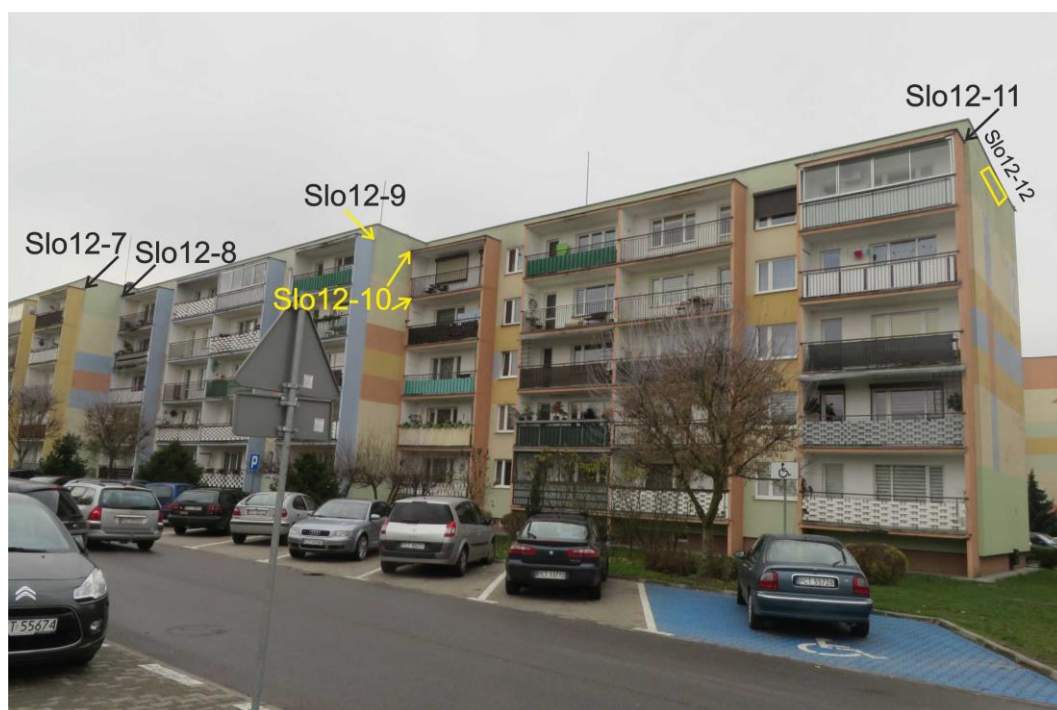
Ryc. 5. Część północno-wschodnia budynku na os. Słowackiego 12 z zaznaczeniem pozycji opisanych w tekście
