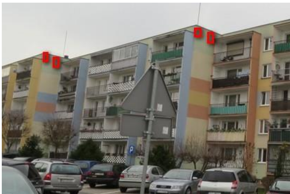
Ryc. 39. Miejsce zawieszenia skrzynek lęgowych dla kawki (czerwone prostokąty) na północno-wschodniej części budynku.
