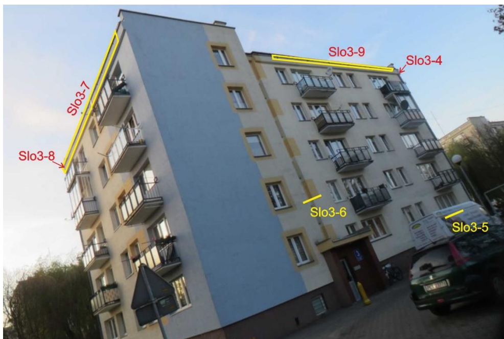
Ryc. 3. Ściany południowo-wschodnie budynku na os. Słowackiego 3 z zaznaczeniem pozycji opisanych w tekście
