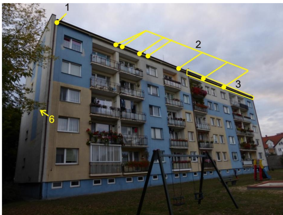
Ryc. 7. Ul. 27 Stycznia 7 – elewacja wschodnia z zaznaczeniem siedlisk zwierząt
