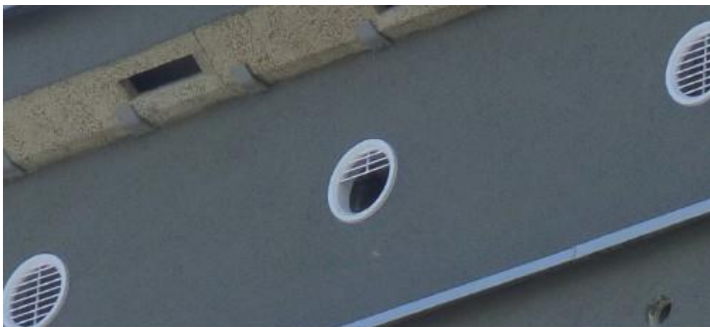
Ryc. 63. Kratka wentylacji stropodachu z wyłamanymi lamelkami (za: Zyskowski i Zielińska 2015).
