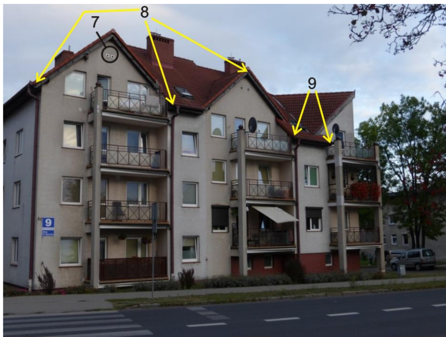
Ryc. 11. Ul. 27 Stycznia 9 – elewacja zachodnia z zaznaczeniem siedlisk zwierząt
