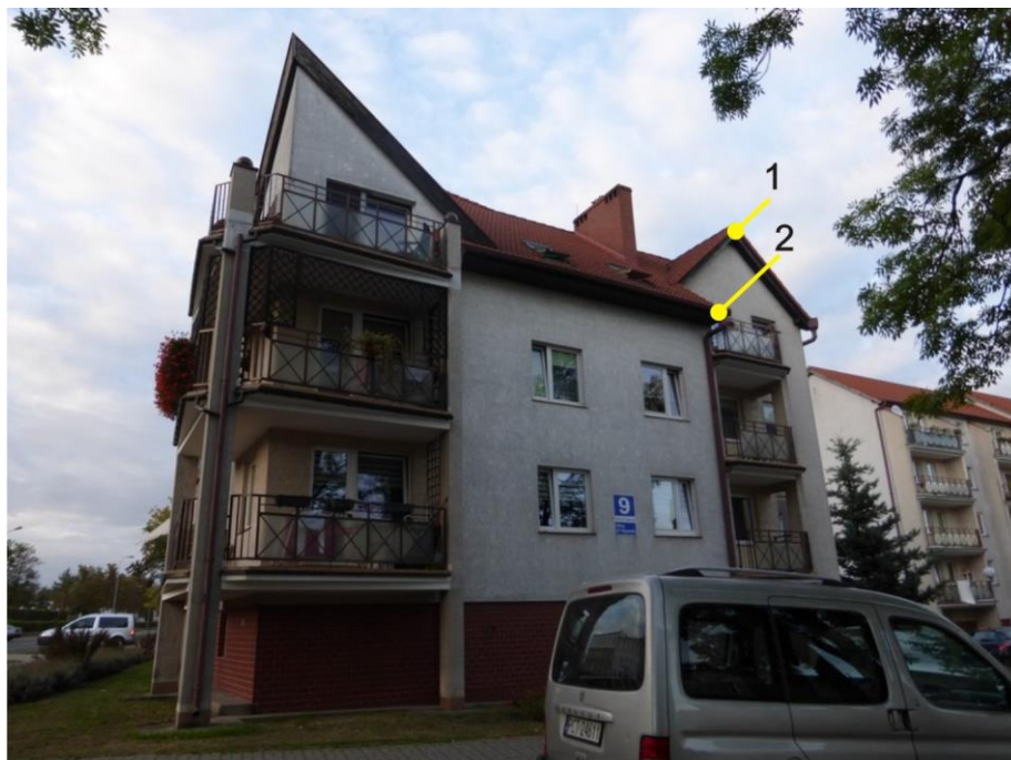
Ryc. 9. Ul. 27 Stycznia 9 – elewacja południowa z zaznaczeniem siedlisk zwierząt
