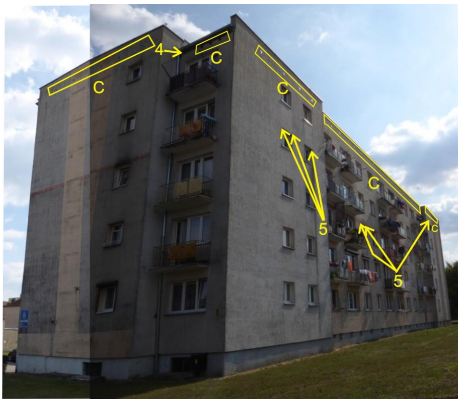
Ryc. 20. Os. Słowackiego 6 – elewacja zachodnia i północna z zaznaczeniem siedlisk zwierząt
