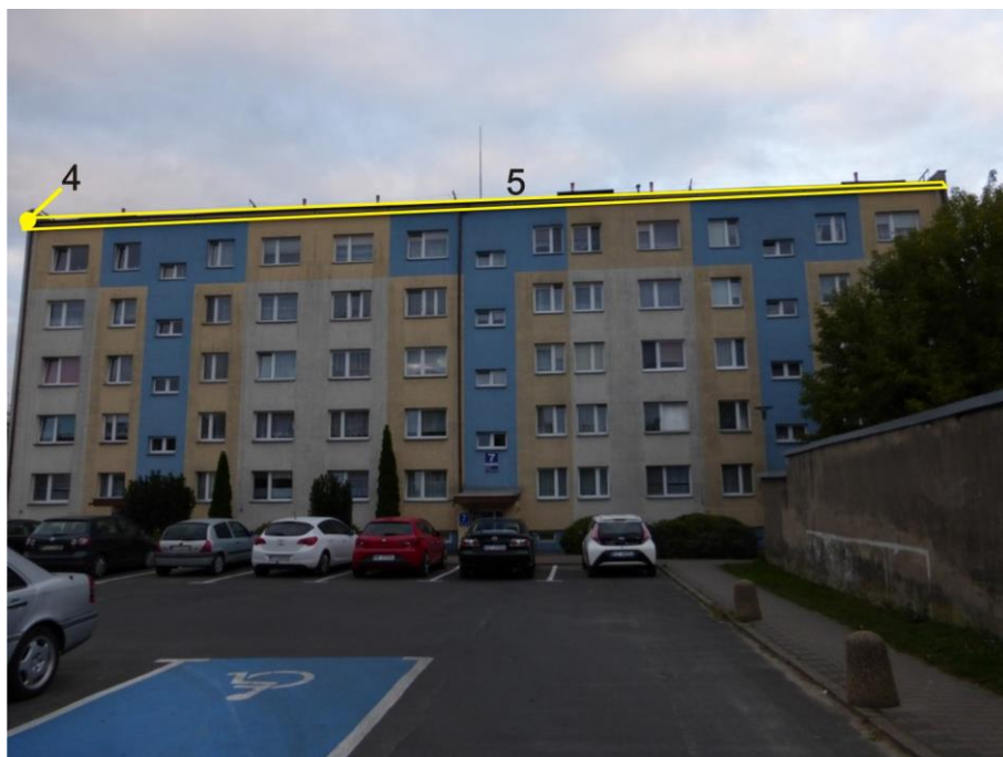
Ryc. 8. Ul. 27 Stycznia 7 – elewacja zachodnia z zaznaczeniem siedlisk zwierząt
