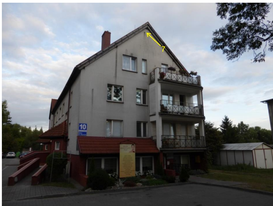
Ryc. 15. Ul. 27 Stycznia 10 – elewacja zachodnia z zaznaczeniem siedlisk zwierząt
