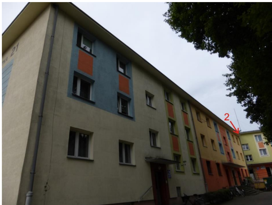
Ryc. 1. Ul. Grunwaldzka 21 – elewacja północna z zaznaczeniem siedlisk zwierząt
