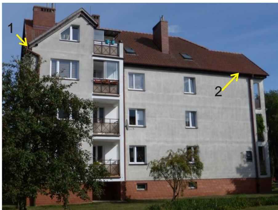
Ryc. 43. Ul. Strażacka 3 – elewacja zachodnia z zaznaczeniem siedlisk zwierząt
