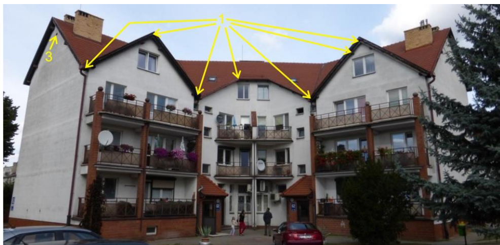
Ryc. 36. Ul. Mickiewicza 62 – elewacja południowa z zaznaczeniem siedlisk zwierząt
