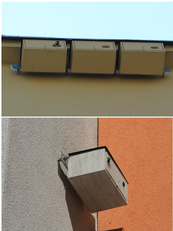
Ryc. 83. Przykładowy sposób zamocowania budek trocinobetonowych do budynku – za pomocą płaskownika i kotew. Pierwsza od lewej budka dla jerzyka oraz dolna lewa budka zajęta sjęst przez wróbla.
