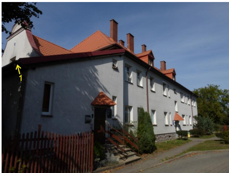
Ryc. 29. Ul. Mickiewicza 21 – elewacja wschodnia z zaznaczeniem siedlisk zwierząt
