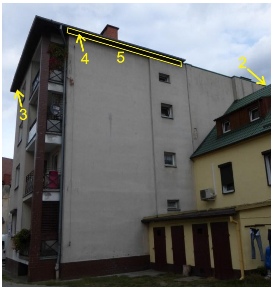
Ryc. 27. Ul. Kościuszki 10 – elewacja południowa z zaznaczeniem siedlisk zwierząt
