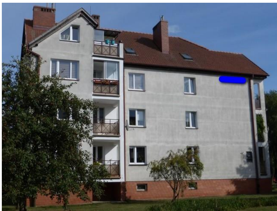
Ryc. 82. Zachodnia ściana budynku: miejsce zawieszenia skrzynek podtynkowych dla nietoperzy (niebieska linia).
