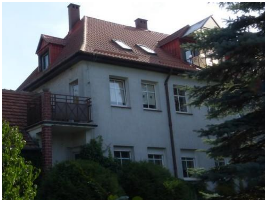
Ryc. 30. Ul. Mickiewicza 21 – elewacja zachodnia i północna
