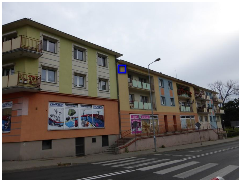
Ryc. 50. Miejsce zawieszenia skrzynek podtynkowych dla nietoperzy (niebieski prostokąt) na ścianie południowej.
