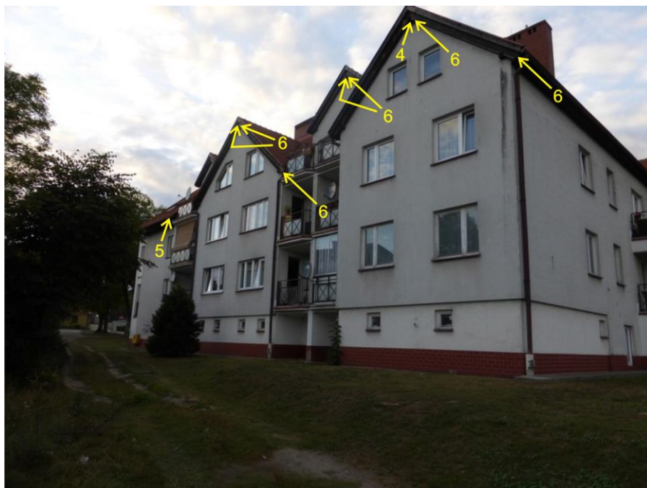
Ryc. 14. Ul. 27 Stycznia 10 – elewacja południowa z zaznaczeniem siedlisk zwierząt
