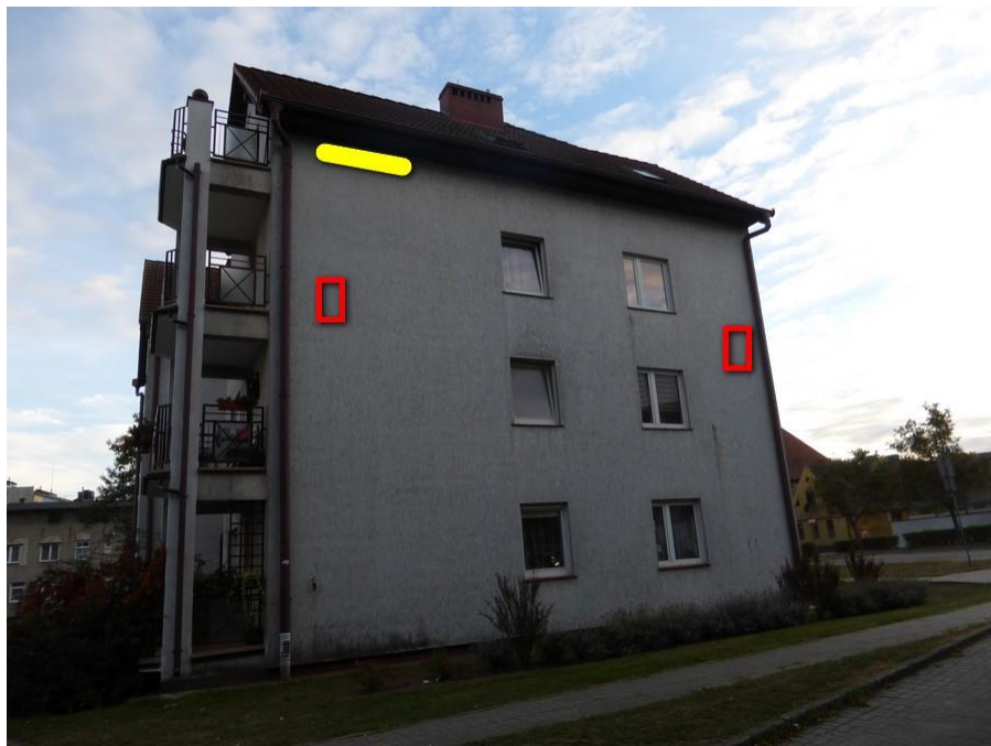
Ryc. 57. Północnej ściana budynku: miejsce zawieszenia skrzynek dla jerzyków (żółta linia) oraz budek dla kawek (czerwone prostokąty).
