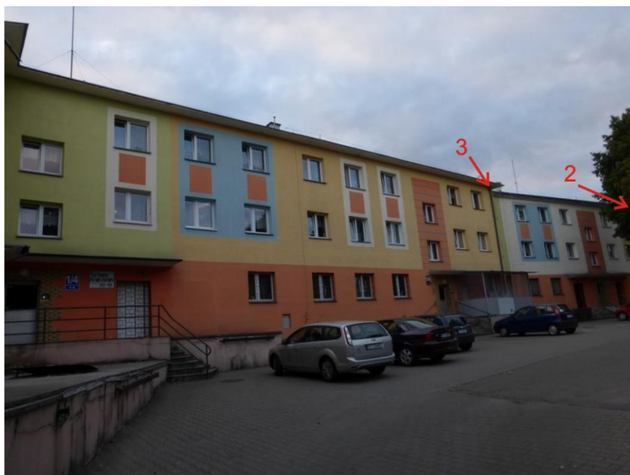
Ryc. 4. Ul. 27 Stycznia 1/4 w Trzciance – elewacja zachodnia z zaznaczeniem siedlisk zwierząt
