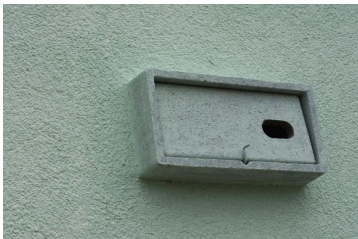
Ryc. 84. Przykładowa budka trocinobetonowa dla jerzyka, tu – wklejona w warstwę termoizolacyjną budynku na wysokości stropodachu (źródło: http://budkilegowe.com/ ).
