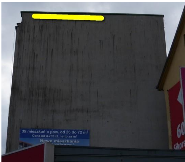
Ryc. 71. Północna ściana budynku: miejsce zawieszenia skrzynek dla jerzyków (żółta linia).
