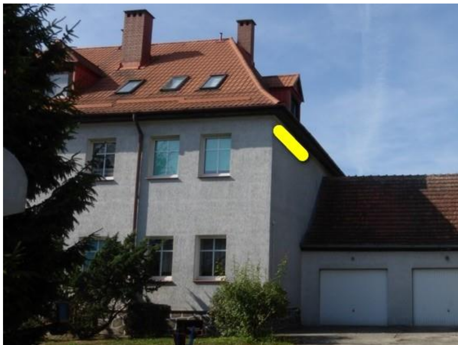
Ryc. 73. Północna ściana budynku: miejsce zawieszenia skrzynek dla jerzyków (żółta linia).
