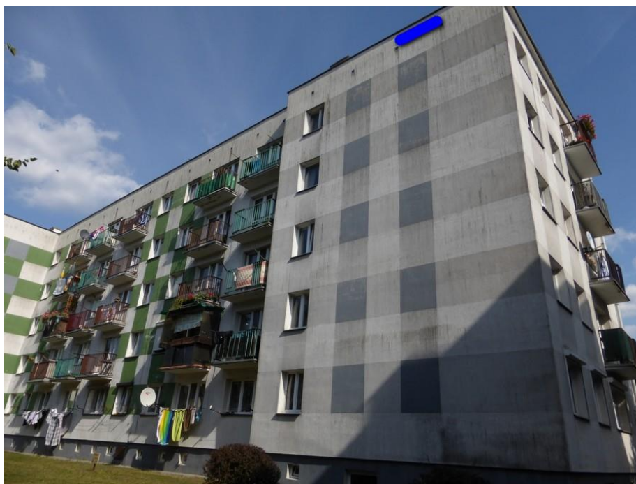
Ryc. 70. Wschodnia ściana budynku: miejsce zawieszenia skrzynek podtynkowych dla nietoperzy (niebieska linia).
