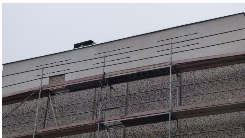
Ryc. 85. Budki podtynkowe dla nietoperzy – przykład ściany bloku z 30 dużymi budkami dla nietoperzy.
