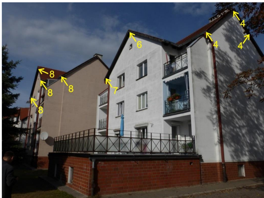
Ryc. 35. Ul. Mickiewicza 60 – elewacja południowo-zachodnia z zaznaczeniem siedlisk zwierząt
