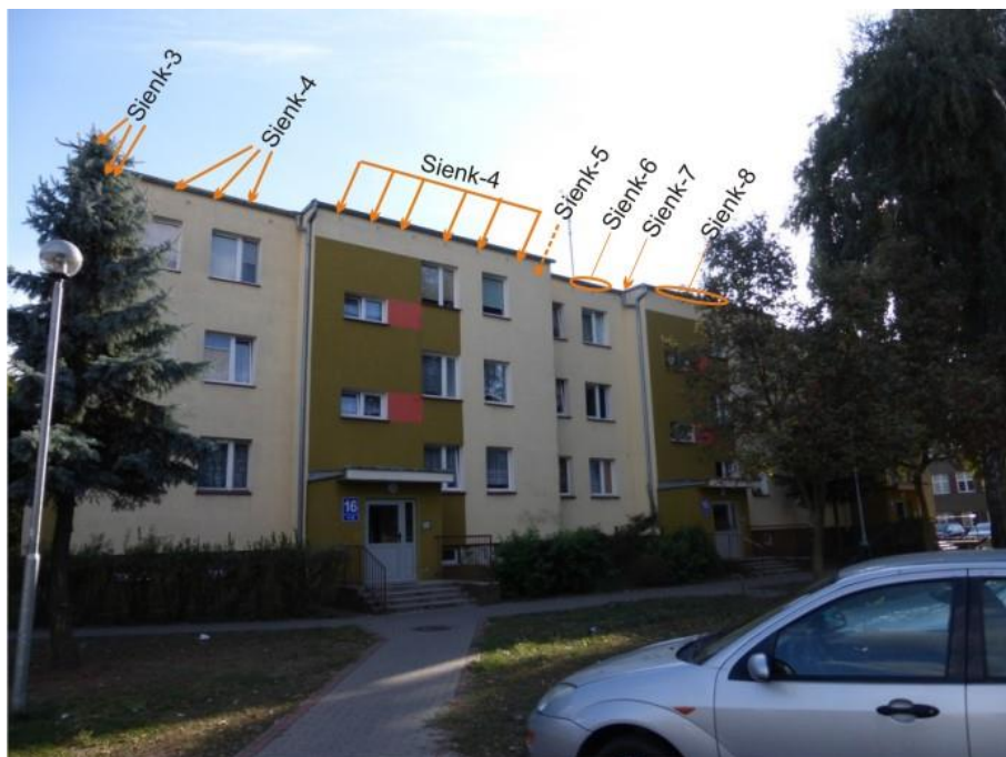
Ryc. 7. Ul. Sienkiewicza 16 w Krzyżu Wlkp. – elewacja północna z zaznaczeniem siedlisk zwierząt
