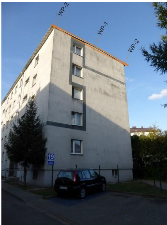
Ryc. 9. Ul. Wojska Polskiego 19 w Krzyżu Wlkp. – ściana szczytowa południowa z zaznaczeniem siedlisk zwierząt
