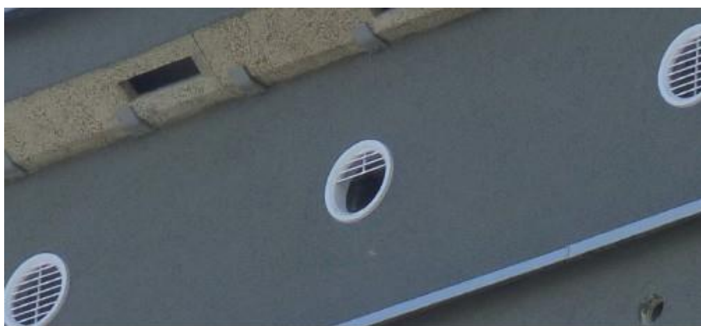
Ryc. 53. Kratka wentylacji stropodachu z wylamanymi lamelkami (za: Zyskowski i Zielińska 2015).
