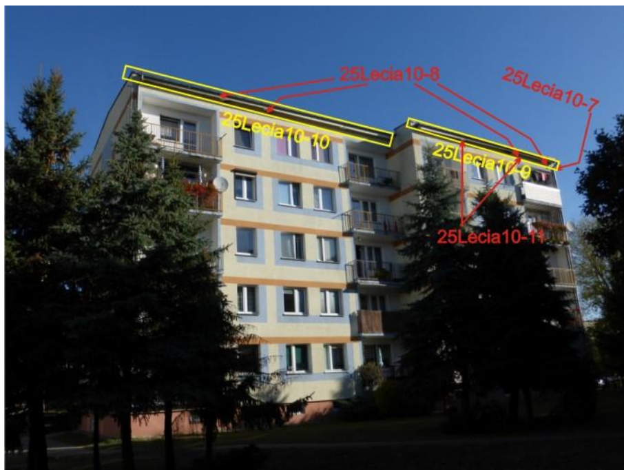
Ryc. 24. Os. 25-Lecia 10 w Trzciance – elewacja południowa z zaznaczeniem siedlisk zwierząt
