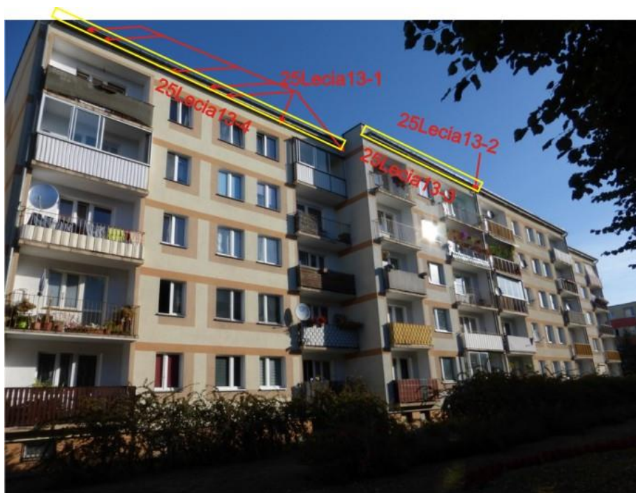
Ryc. 28. Os. 25-Lecia 13 w Trzciance – elewacja południowa z zaznaczeniem siedlisk zwierząt
