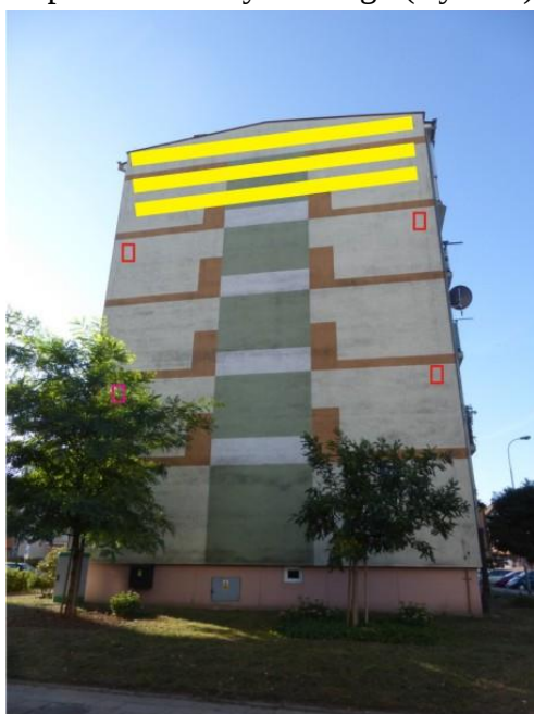
Ryc. 59. Miejsce zawieszenia skrzynek lęgowych dla jerzyka (żółta linia) oraz budek dla kawki (pomarańczowe prostokąty) na ścianie szczytowej północnej oraz skrzynek podtynkowych dla nietoperzy (niebieska linia) na ścianie szczytowej południowej.
