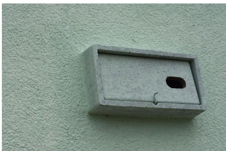
Ryc. 71. Przykładowa budka trocinobetonowa dla jerzyka, tu – wklejona w warstwę termoizolacyjną budynku na wysokości stropodachu (źródło: http://budkilegowe.com/ ).
