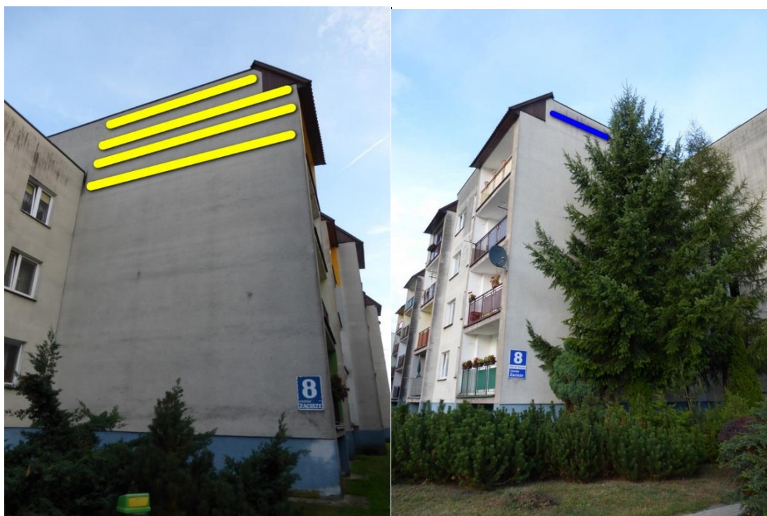
Ryc. 66. Miejsce zawieszenia skrzynek lęgowych dla jerzyka na ścianie szczytowej północnej (żółta linia) oraz skrzynek podtynkowych dla nietoperzy (niebieska linia) na ścianie szczytowej południowej.
