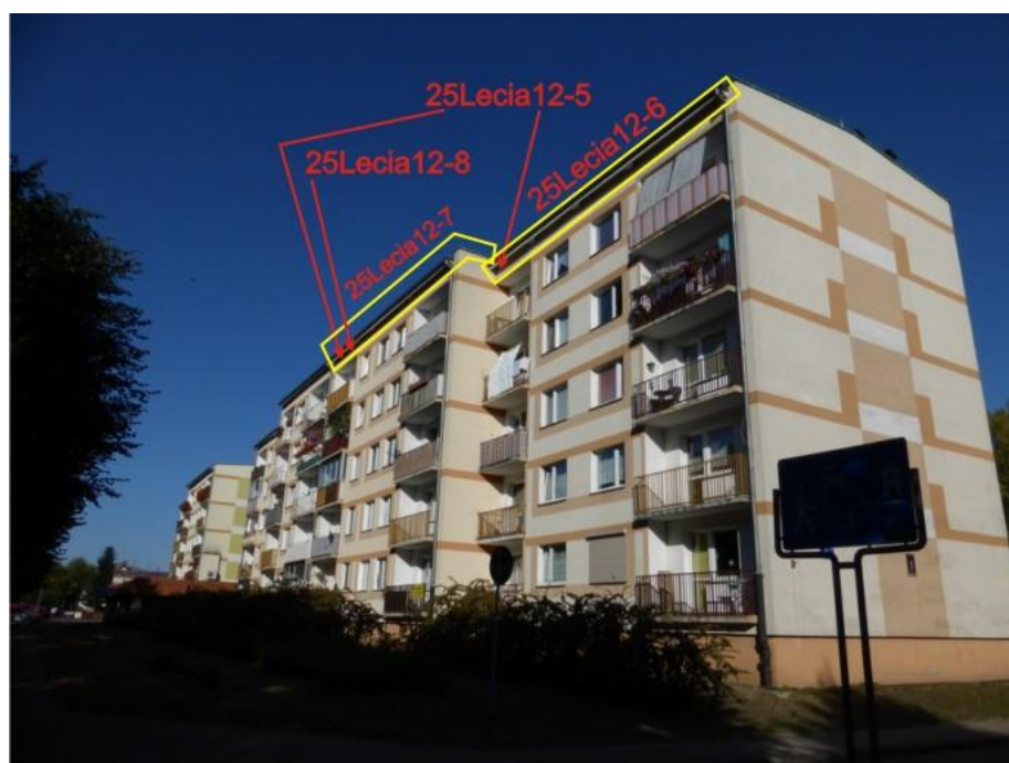
Ryc. 26. Os. 25-Lecia 12 w Trzciance – elewacja południowa z zaznaczeniem siedlisk zwierząt
