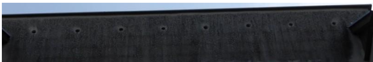
Poz. OZ8-6. W sumie 25 otworów średnicy 6-7 cm do stropodachu wentylowanego, pod niektórymi delikatne przetarcia osadu na ścianie (wiedzę o tym czy są używane można powziąć jedynie w sezonie lęgowym, gdyż czasem wchodzące ptaki na danej strukturze tynku lub substancji, którą jest pokryta ściana nie zostawiają śladów) – 25 potencjalnych siedlisk jerzyka lub wróbla, nietoperzy.
