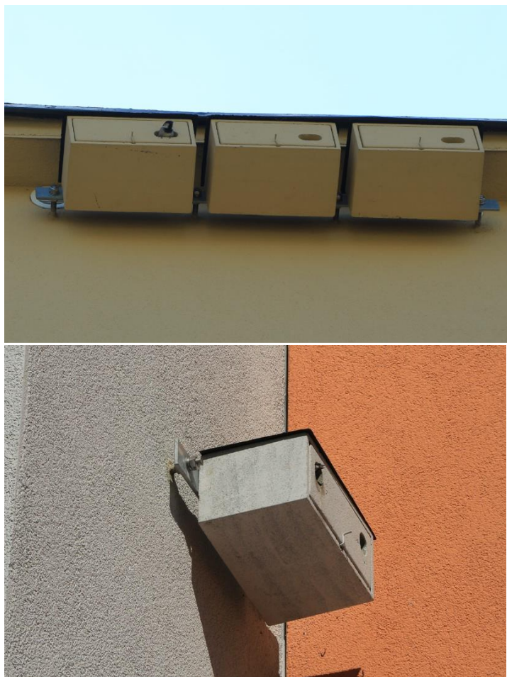
Ryc. 70. Przykładowy sposób zamocowania budek trocinobetonowych do budynku – za pomocą płaskownika i kotew. Pierwsza od lewej budka dla jerzyka oraz dolna lewa budka zajęta sjęt przez wróbla.
